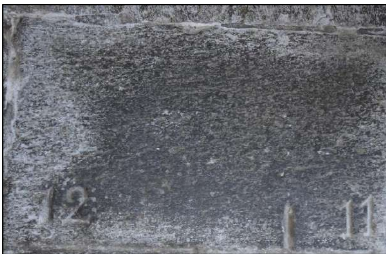
Utilisation de l'ardoise de Caurel pour le dallage de la Chapelle du Sépulcre (photo GM)
