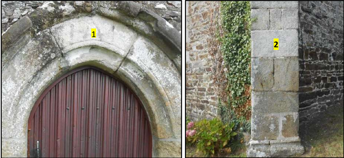
Granite de l'Île-Grande, en restauration : 1 : portail ; 2 : pilier extérieur (photos GM)
