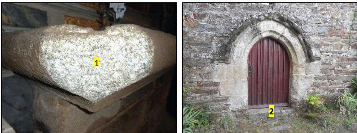
Granodiorite de Saint-Brieuc : 1 : angle de l'autel ; 2 : seuil du portail sud (photos GM)
