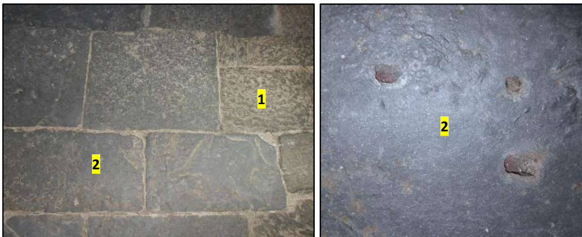
Dallage du sol en ardoise de Caurel : 1 :sur chant ; 2 : à plat (avec cristaux de pyrite oxydés)
