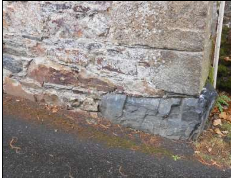
Affleurement d'amphibolites sous le mur nord de la Chapelle de Saint-Eloi
